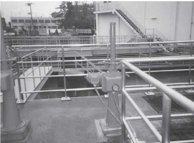
電動スピンドル式 LTKD-02形 0.7m×0.7m 制水扉 浄水場設備
